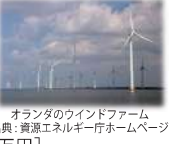
オランダのwindファーム (出典:資源エネルギー庁ホームページ)
