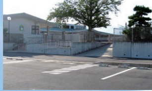
竹永幼稚園改築(園庭・駐車場拡張と通路整備)
