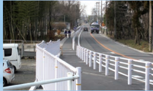
県道田光四日市線歩道整備および八風橋交差点改良
