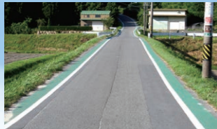
町道朝上石樽線グリーンベルト帯設置
